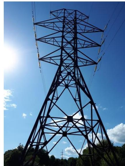
Q: 测量时需要某个目标点到地面的高度信息，且目标点悬空无法放置棱镜，如图中电力应用时，需要测得输变电缆最大弧垂处离地面的高度。
